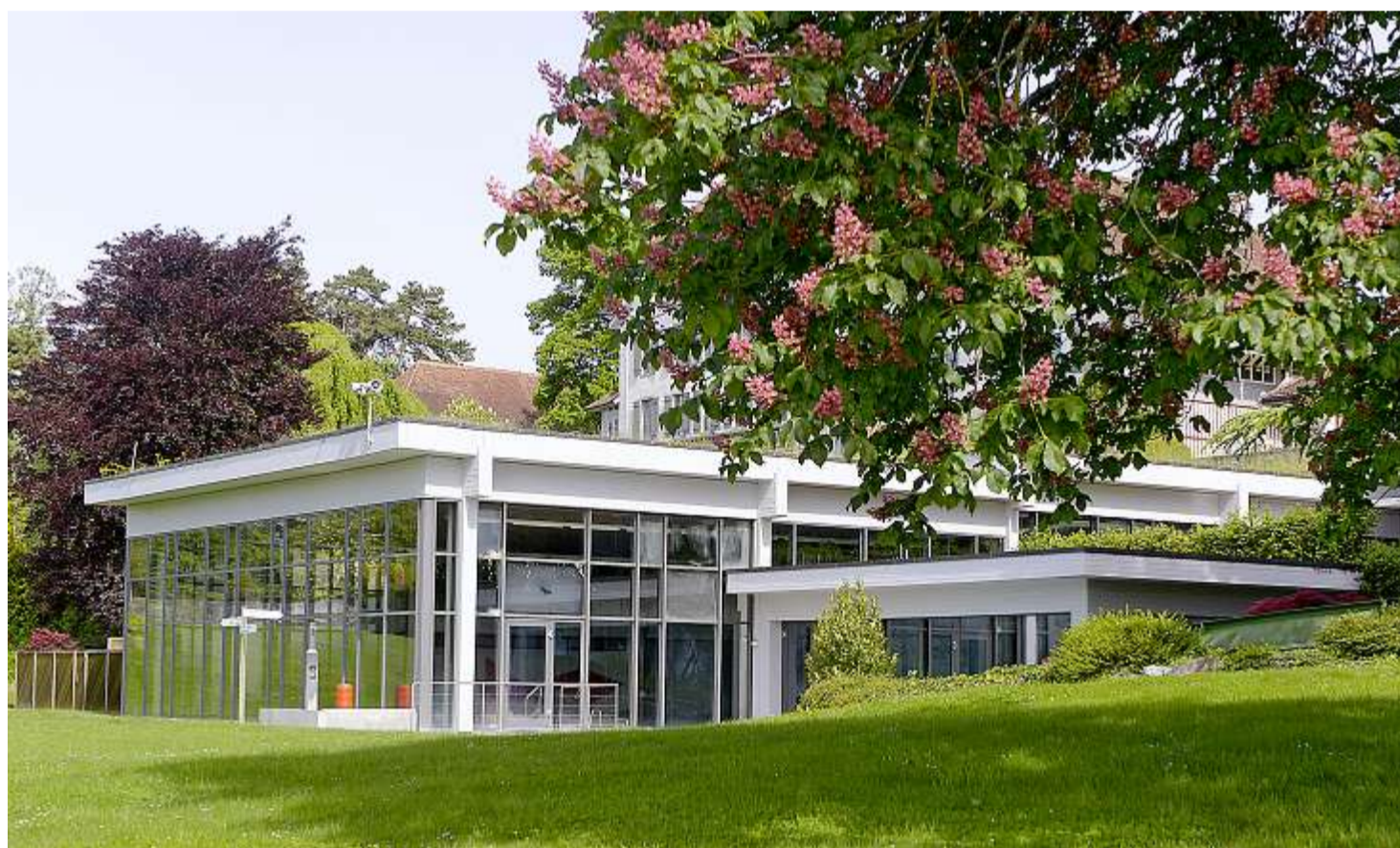
Das Hallenbad Oberhofen soll in Bälde saniert und erweitert werden, damit es selbsttragend geführt werden kann. Patric Spahni
