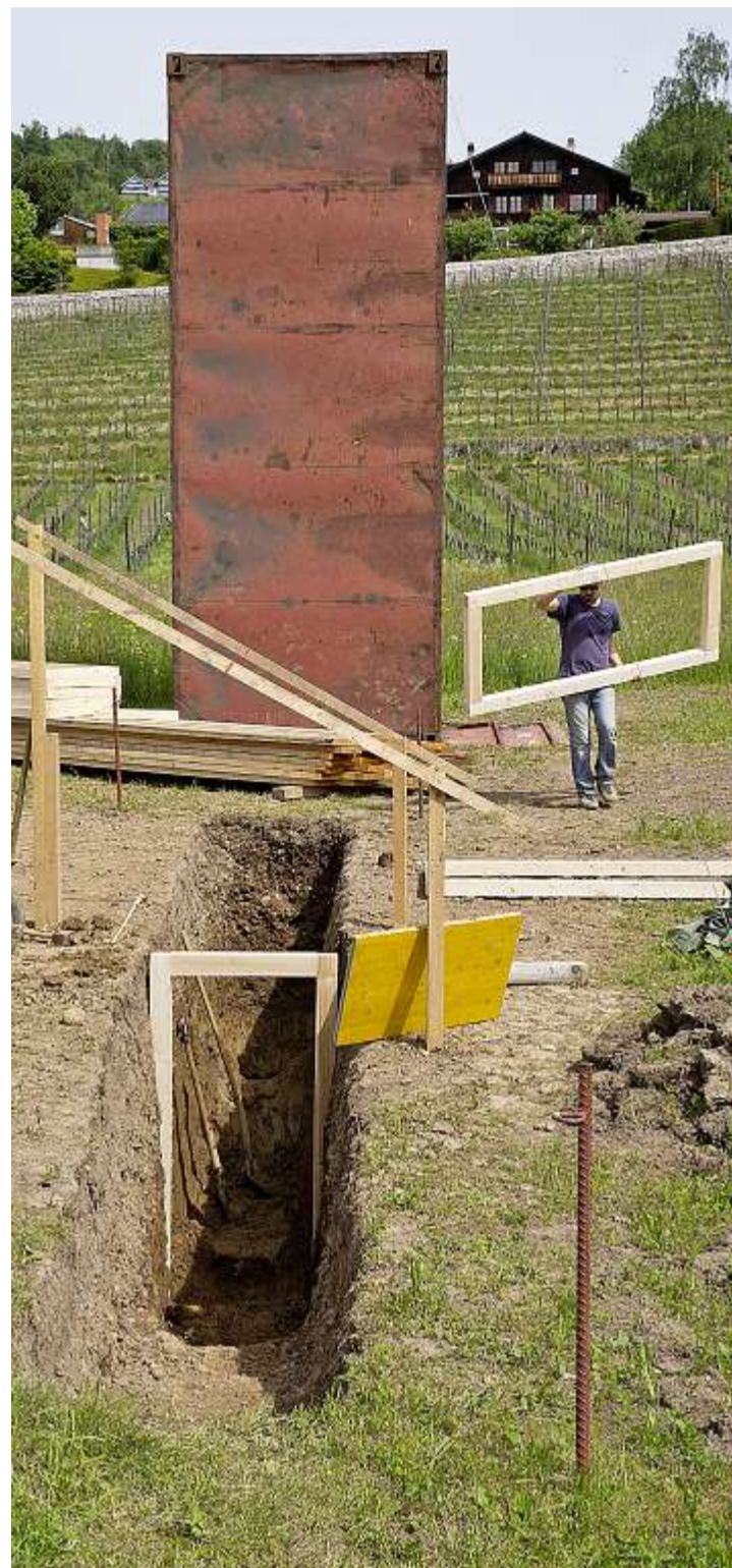
Der Container von Reto Steiner wird nur über einen Tunnel erreichbar sein.
